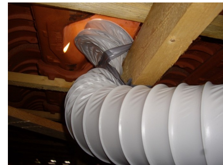
Caisson de ventilation – Gaine de rejet d'air vicié non raccordée sur l'extérieur
