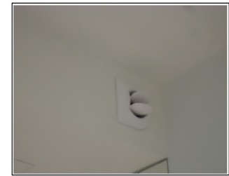
Exemple de non-conformité Bouche de soufflage à flux orientable (bouche à ailettes) implantée dans une pièce de service (WC), en lieu et place d'une bouche d'extraction WC
